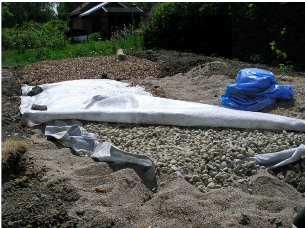
Figur 4. Filterbädden för duschvattenrening under byggnation maj 2007.
