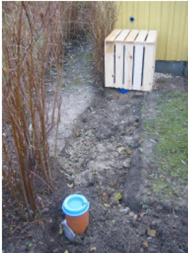
Figur2. Köksavloppet kräver plats just utanför köksväggen. Resoptionsdiket placeras lämpligen efter en häck och inskränker ej nyttjande av tomten.
